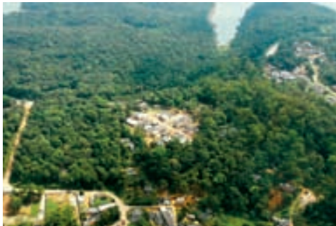
Área de Proteção Permanente invadida por urbanização irregular no compartimento ambiental Capivari – Pedra Branca, da Bacia Billings.
