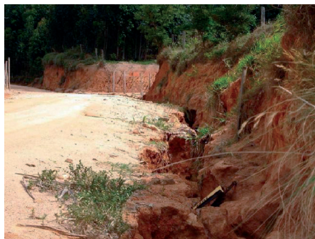
Figura 3. Perigosa vala de erosão em estrada rural municipal, em Campinas, SP. Foto: Paulo Espíndola Trani, 2005 (Instituto Agrônômico, SP)
