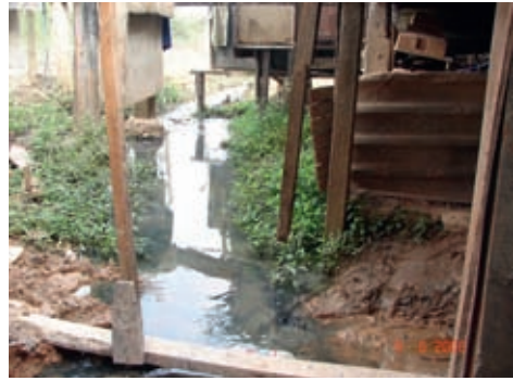
Figura 3.11 - Construção em palafita sobre curso d'água no Município de Cotia/SP. Fotos: Acervo do IG (2006).
