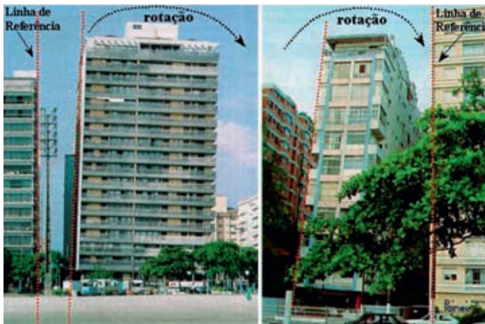
Figura 6.5 - Recalques diferenciais em edificações construídas sobre sedimentos de argilas moles na orla de Santos-SP. (Fonte: Hachich, 1997).
