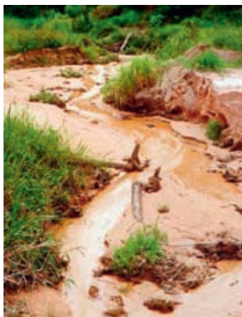
Figura 4.4 - Processo de assoreamento em drenagem em Americana, SP. (Fonte: Acervo IG, 1995).
