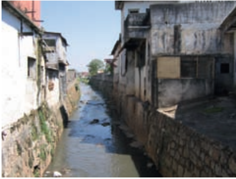
Figura 3.10 - Construções irregulares em margens de córregos no Município de Poá/SP, em 2006. Fotos: Acervo IG
