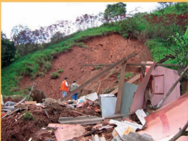
Escorregamento em Campo Limpo, SP, 2009. Fonte: Acervo IG.
