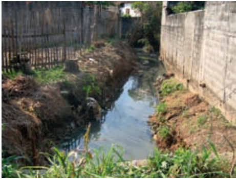
Figura 3.12 - Construções irregulares em margens de córregos no Município de Poá/SP, em 2006. Fotos: Acervo IG
