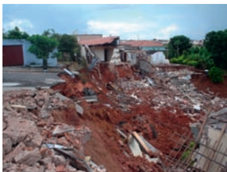
Figura 4.8 - Moradias destruídas por processo erosivo, na forma de boçoroca, na cidade de Monte Alto-SP. (Fonte: Acervo IG, 2007).
