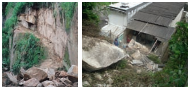
Figura 2.6 - Queda de blocos rochosos em Santos, 1992 e 2009. Fonte: Acervo IG.
