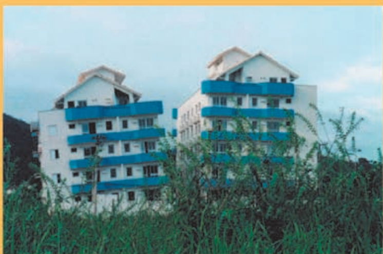
Subsidência de solos em Ubatuba, 2002. Fonte: Acervo IG.
