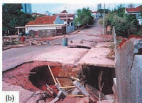
Figura 10.5 - Mapeamento de risco associado a inundação no município de Jaboticabal, SP: (a) Setorização e classificação das áreas de risco (IG, 2005); (b) detalhe da ruptura do sistema de águas pluviais ocorrido em 1999, em consequência de evento de inundação (Fonte: Acervo PM Jaboticabal).
