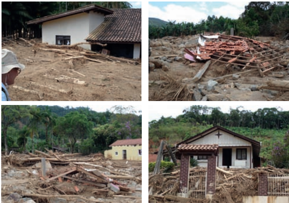
Figura 2.8 - Diversidade de materiais transportados pelos processos de corridas de detritos nos desastres que assolaram o Estado de Santa Catarina em novembro de 2008, no município de Ilhota (Braço do Baú). Fonte: Acervo IG.
