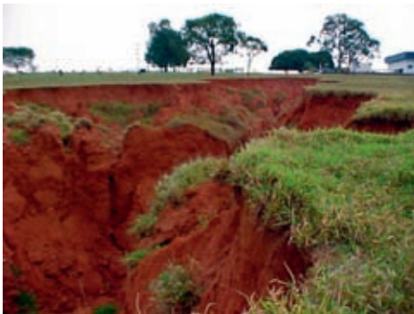
Figura 4.2 - Processo erosivo na forma de boçoroca, na cidade de Rancharia - SP. (Fonte: Arquivo IG, 2001)
