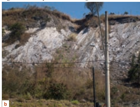
Figura 2.5 - Escorregamento em cunha em: (a) Quartzito em Rio Acima, MG; (b) Talude de filito alternado com quartzito da Formação Cercadinho em Belo Horizonte, MG. Fonte Parizzi, 2004.
