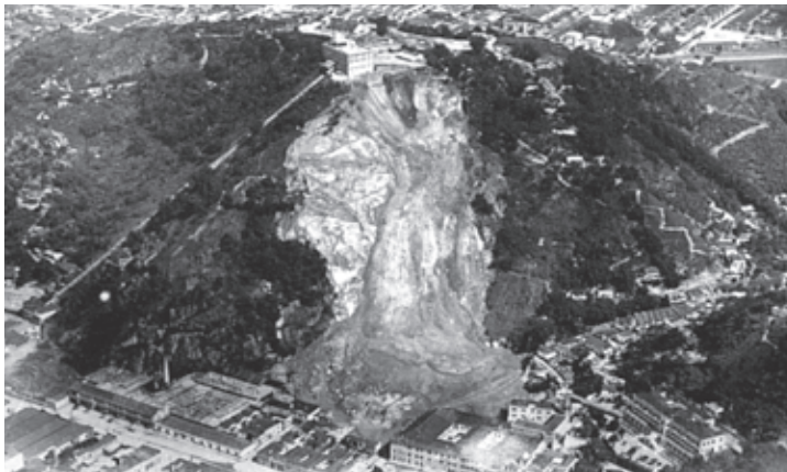
Figura 2.2 - Escorregamento rotacional do grande acidente do Monte Serrat, em Santos (1928), com 80 mortes e destruição de parte da antiga Santa Casa. Fonte: Arquivo e Memória de Santos, P. M. de Santos.
